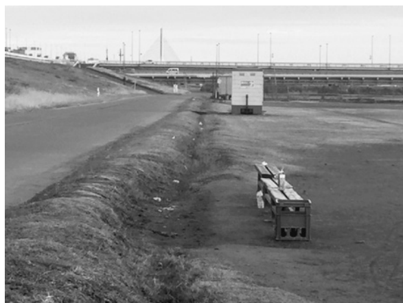
図 1 実際に足を取られ転倒したあたり。側溝はすべてのグラウンドの一塁線方向・三塁線方向に掘られている。深さや幅は様々でグラウンドから走っていったときの障害物はない。
