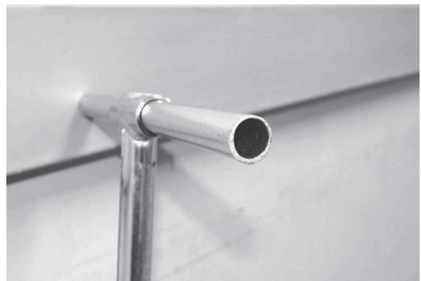
写真11 バーエンド部分。元々ゴム製ラバーがついていたが、長年の使用により外れており、内部の金属が露出していた。
