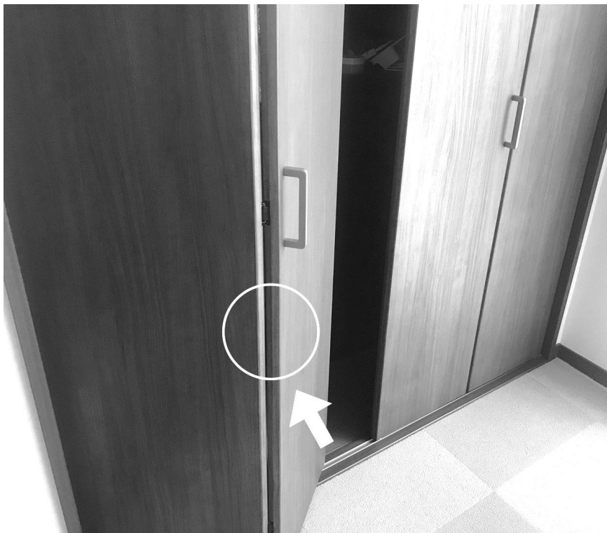
【図 1】現場の写真。祖父母宅のクローゼットの折れ戸式扉（矢印部分で受傷した）
